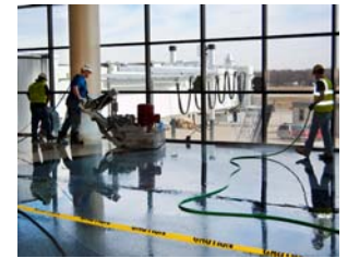
Completing the terrazzo.
